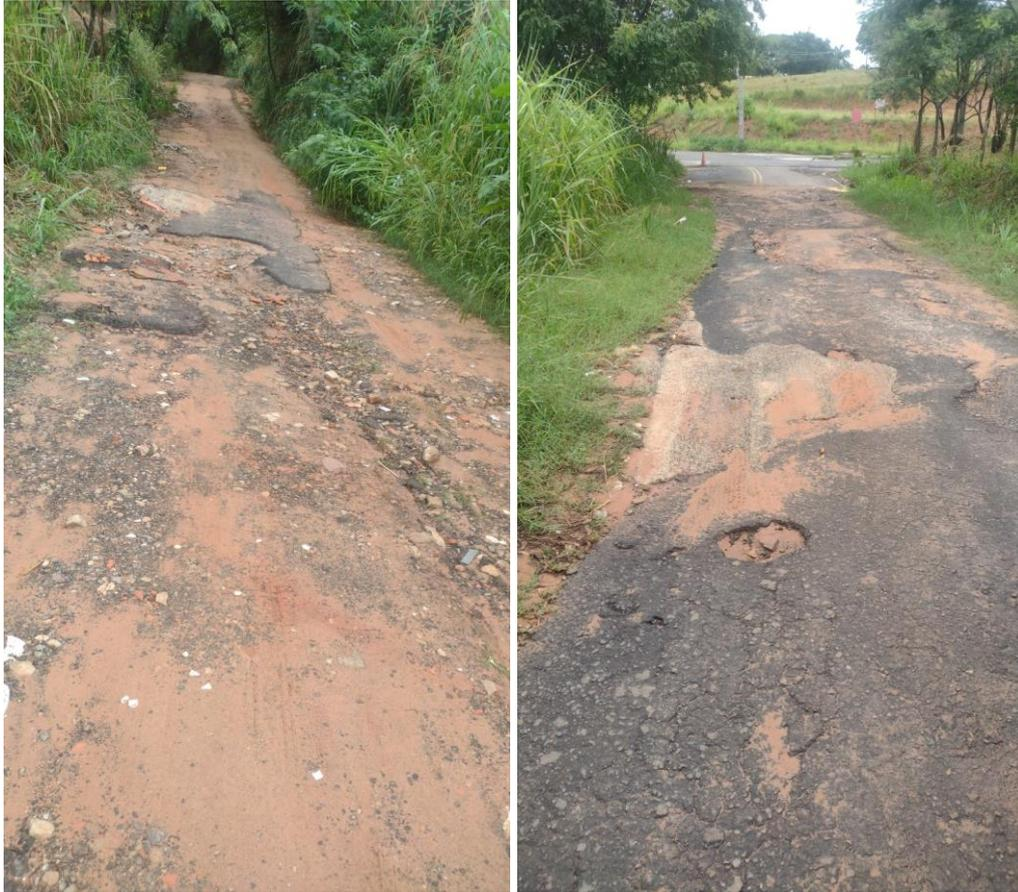
A via encontra-se em estado precário, com trechos de asfalto totalmente deteriorado, acúmulo de terra e detritos, o que oferece risco à segurança de pedestres e motoristas, especialmente em dias de chuva, quando a estrada se torna praticamente intransitável.
