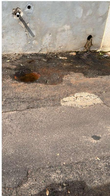
Além disso, moradores relataram que há escoamento inadequado de águas provenientes das residências, que acabam sendo despejadas diretamente na via pública, causando deterioração do asfalto, formação de poças e risco de proliferação de insetos e doenças. Diante disso, solicitamos também informações e providências quanto à regularização do sistema de drenagem da rua.
