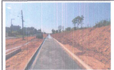
FOTO - 11: CONCRETAGEM PISO
