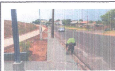
FOTO - 05: CONCRETO CALÇADA
