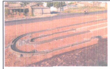
FOTO - 09: GUIA CONCRETO FINAL
