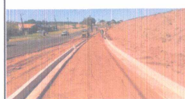
FOTO - 03: GUIA DE CONCRETO
