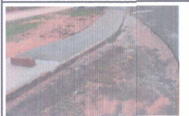
FOTO - 10: CONCRETO CALÇADA
