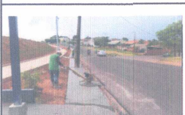
FOTO - 04: CONCRETO CALÇADA
