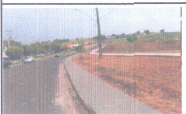
FOTO - 07: CONCRETO CALÇADA
