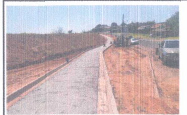
FOTO - 14: CONCRETAGEM PISO
