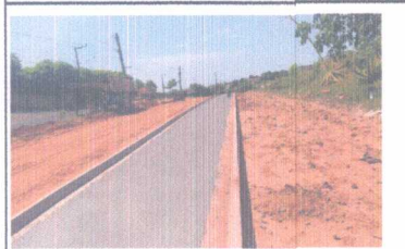
FOTO - 13: CONCRETAGEM PISO
