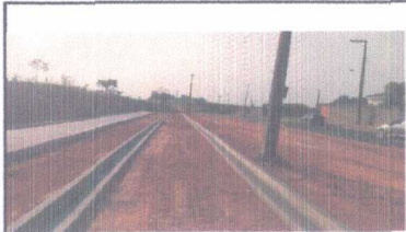
FOTO - 02: GUIA DE CONCRETO
