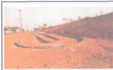
FOTO - 08: GUIA CONCRETO FINAL
