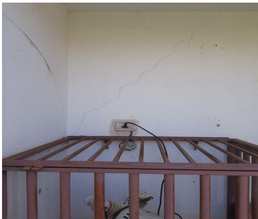
Foto 06 – Rachaduras na parede externa da UBS.
