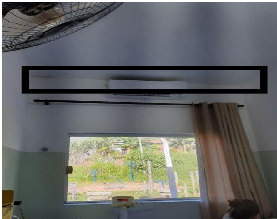
Foto 05 – Manchas escuras no forro, consequência dos problemas de infiltração.
