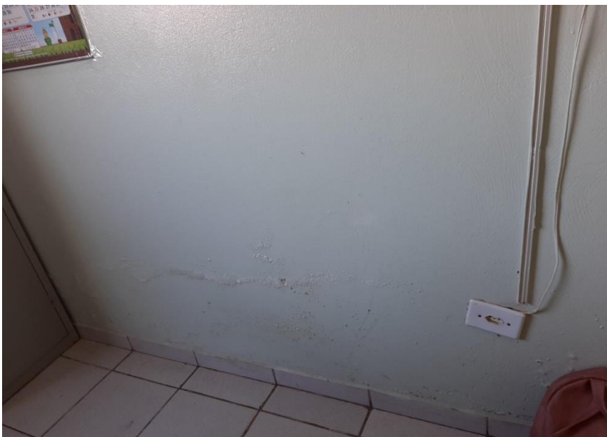
Foto 04 – A infiltração/vazamento da sala do dentista, demonstrada na foto 03, atingiu a parede da sala ao lado.
