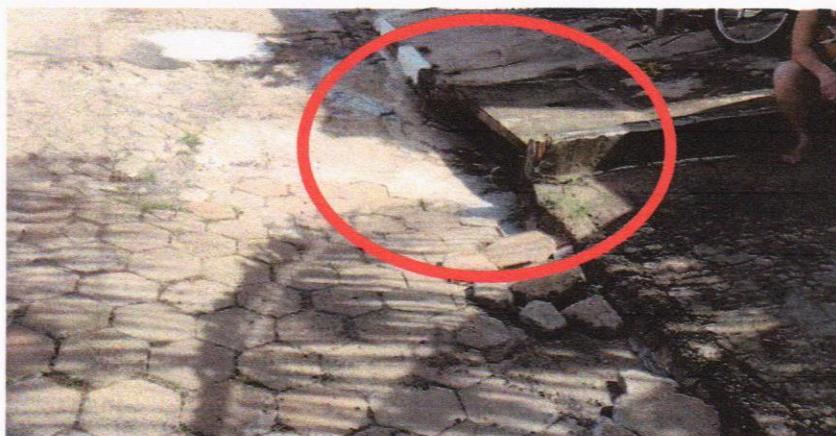
Sugere-se, como possível solução, o alargamento da abertura para escoamento, com a instalação de grades no chão, a fim de melhorar a vazão da água pluvial e evitar novos problemas decorrentes do acúmulo.
