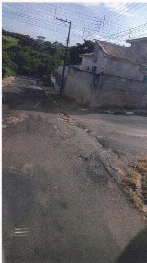
O referido trecho encontra-se bastante danificado, com buracos que dificultam a circulação de veículos e pedestres, podendo causar acidentes e danos materiais. Além disso, a construção da canaleta se faz necessária para o correto escoamento da água pluvial, evitando o acúmulo de enxurradas e a deterioração precoce do asfalto.
